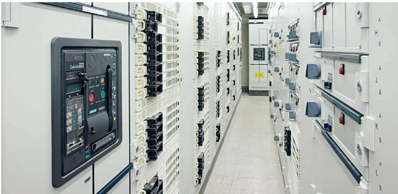
Niederspannungshauptverteilung Siemens Sivacon S8.
